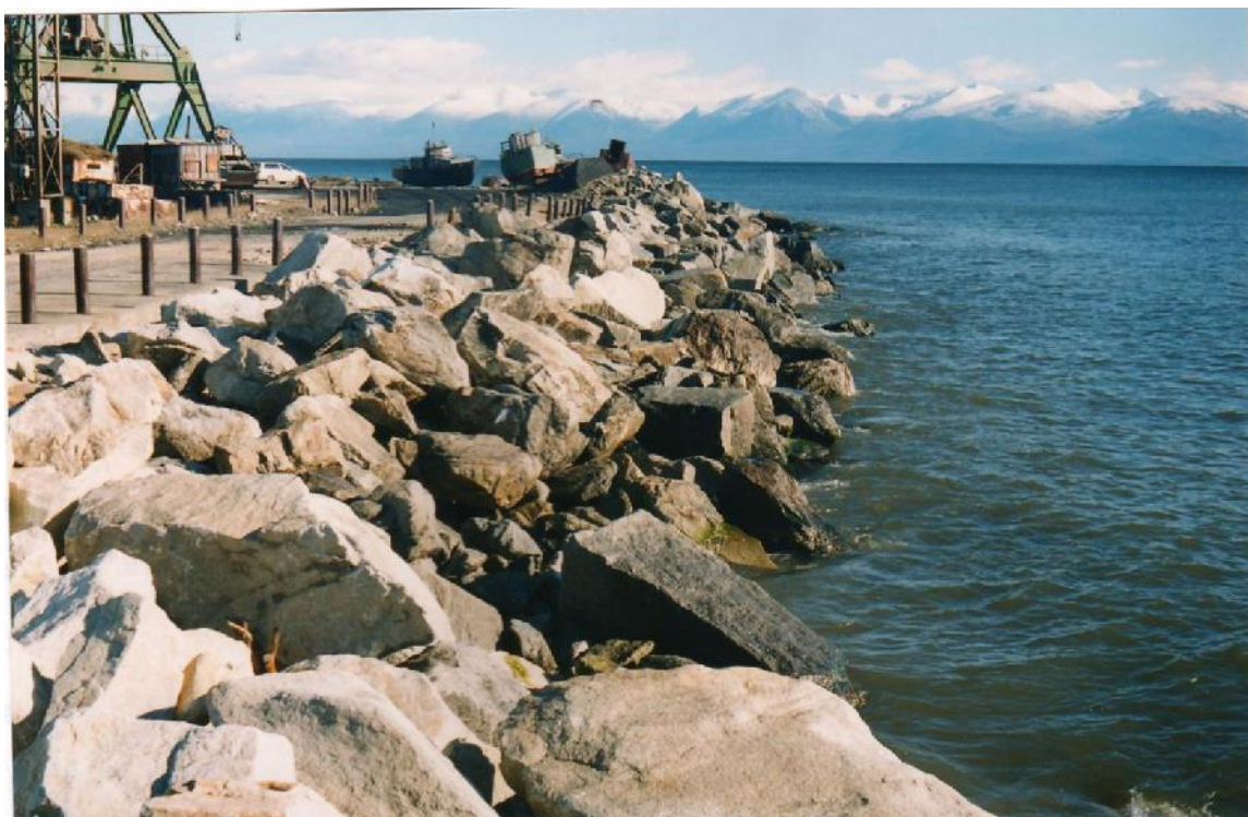
Рисунок 3 - Противоаварийная защита средней части мола (Октябрь 2004 г.)
