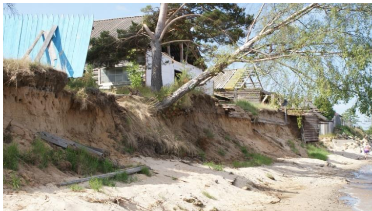
Рисунок 7 – Абразия берега в с. Ст. Энхалук в районе музея невероятной истории Байкала
