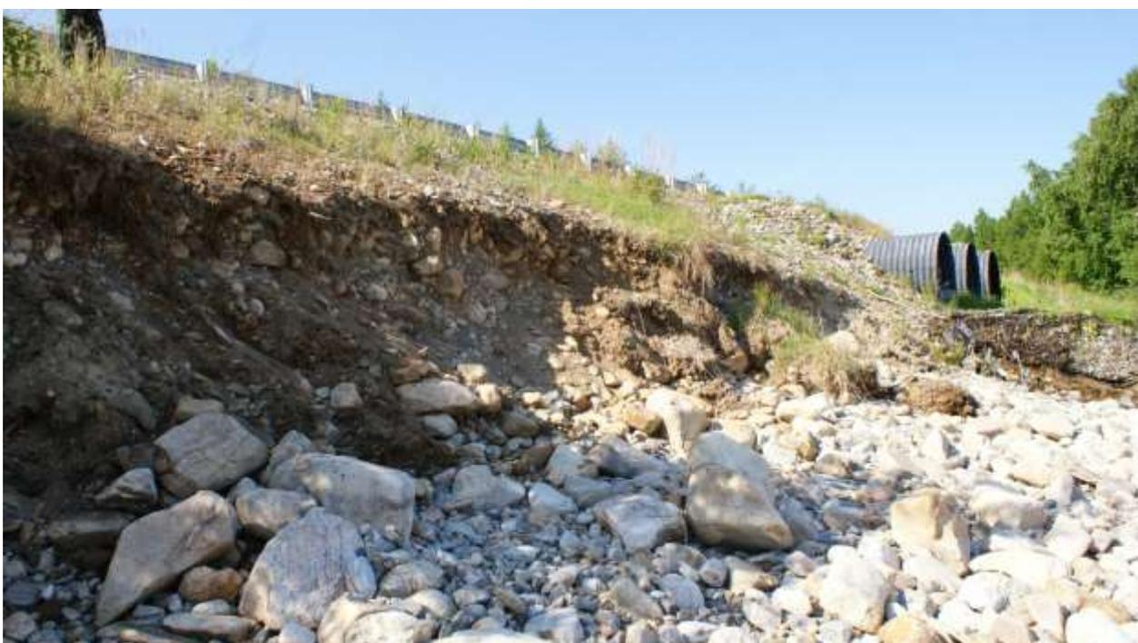
Рисунок 13 – Абразионное разрушение высокой террасы, затронувшее насыпь автомобильной дороги
