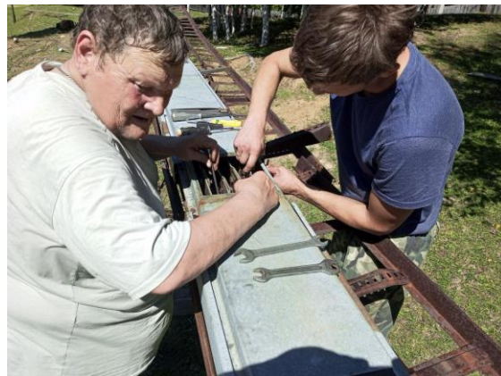
Ремонтные работы на вибрационном источнике ЦВО-100, Кабанский район РБ
