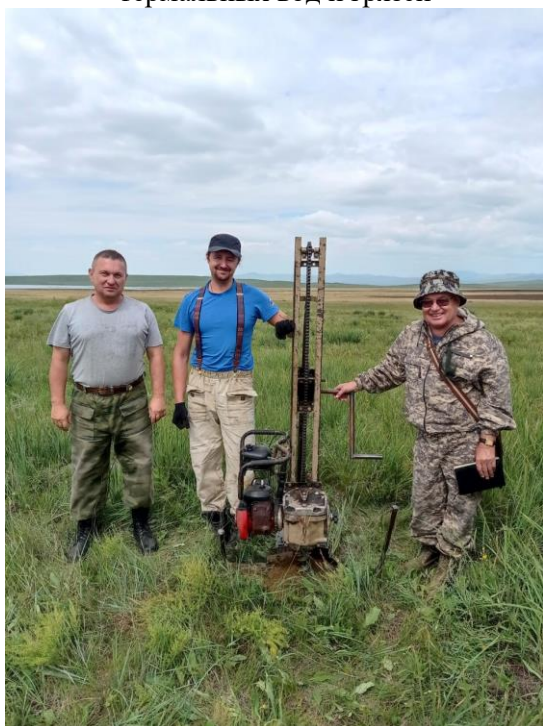
Проведение буровых работ в Боргойской впадине
